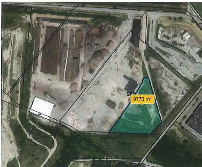
Figure 1 : Localisation de l'installation de co-compostage de bio-déchets et de lombri-compostage
